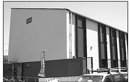
モダンな外観デザインが素敵な中里町友会館。入口にはスロープも付いています。
